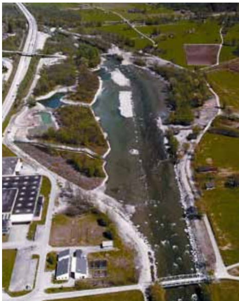
Abb. 9 Moesa bei Grono GR vor (oben) und nach (unten) den Revitalisierungsmassnahmen. Die revitalisierte Strecke ist 600 Meter lang und hat knapp eine Million Franken gekostet.
