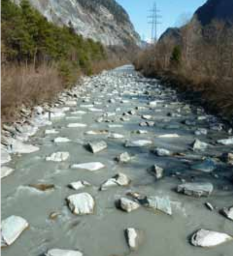
Abb. 13 Hindernisse beseitigt: Eine aufgelöste, umstrukturierte Blockrampe in der Landquart bei Malans GR.
